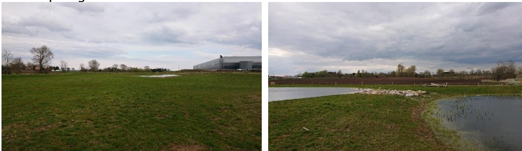
Figur 6: Foto af et etableret konstrueret vådområde i Skensved Ådal fra april 2023. Til venstre et lavbundet areal og til højre vises koblingen mellem to lavninger med en indbygget stentærskel.
